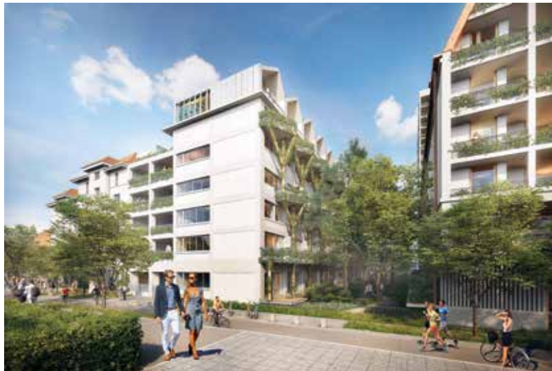
L'Administration est transformée pour accueillir des « lofts bruts », KaléidosCOOP et des bureaux © Nunc + DRLW / Acte2Paysage
