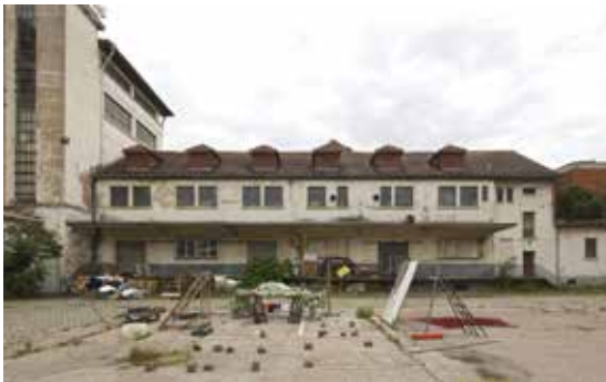
La Sérigraphie avant travaux © A. Duboys Fresney
