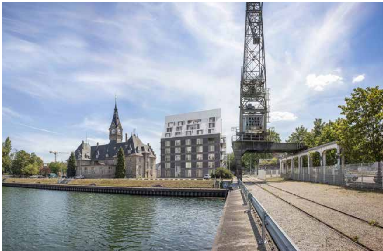
La Maison de la Virgule vue depuis le Bassin du Commerce, dans le port de Strasbourg. À gauche, la capitainerie © Lucquet architectes
