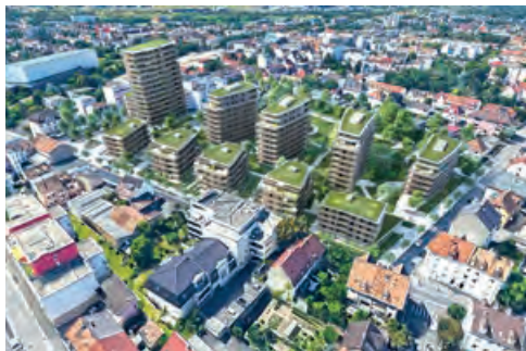
Quartier Archipel 3F, Saint-Louis ©dea architectes / Sortons du Bois
