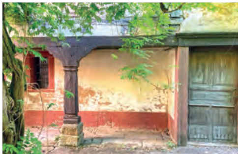
Cour intérieure de la maison historique rue Saint-Jean ©Tina Schnörringer
