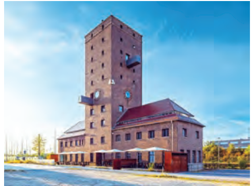
Tankturm Außenansicht ©Thilo Ross
