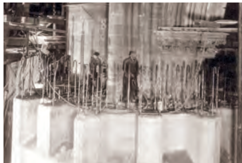
Démolition du corset en béton armé autour du grand pilier portant la tour à l'aide des marteaux piqueurs, 1926 ©Fondation OND
