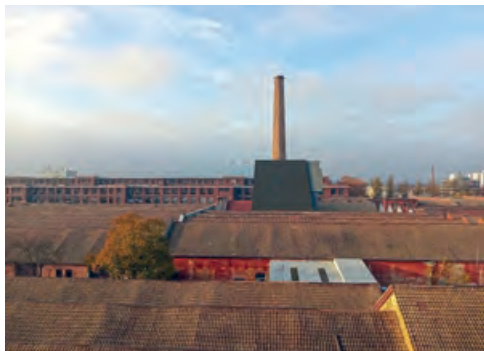
DMC depuis le toit de MOTOCO ©Sabine Guth
