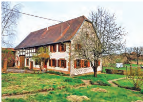
Maison forestière de Weinbourg avant travaux © M. Wehrung et M me Bazière
