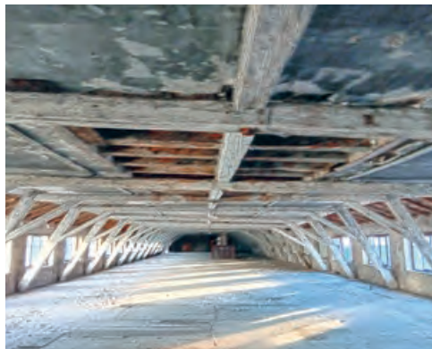
Vue de la charpente existante, Miroir-Cité ©Ville de Mulhouse
