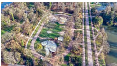
Photo aérienne du chantier ©Vivaparc
