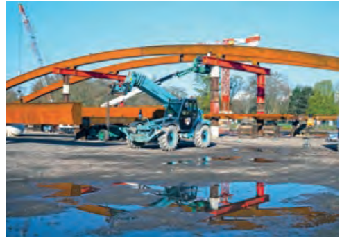
Le chantier de la passerelle Rosa-Luxemburg © Mathilde Cyburski, Ville et Eurométropole de Strasbourg
