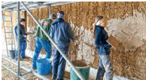
Chantier terre à l'écolieu de Boofzheim ©Manuel Zaepffel – Le Gabion
