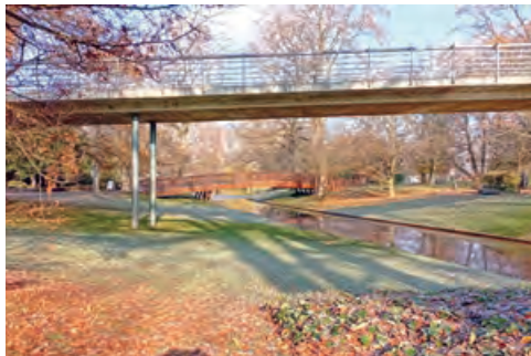
Blick unter Tiergartenwegbrücke Richtung Norden ©Frank Steinbach
