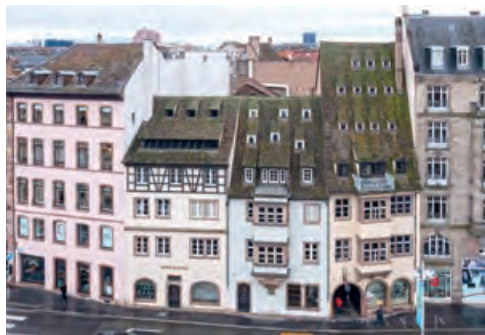
Vue des toitures du Musée alsacien avant travaux ©Julien-Roussel
