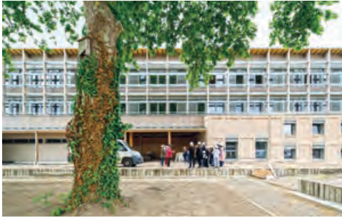
Collège en chantier – grès, briques et bois de réemploi © nunc architectes
