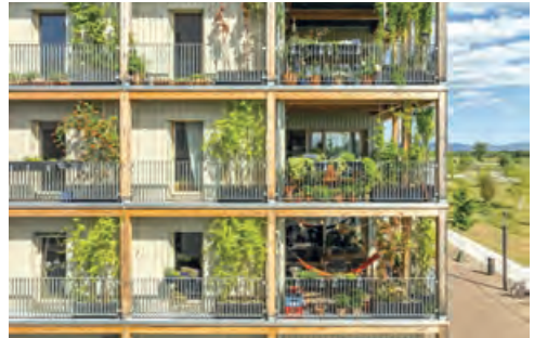
WohnWerk e.G. Mannheim, DGJ Architektur Frankfurt © Thilo Ross
