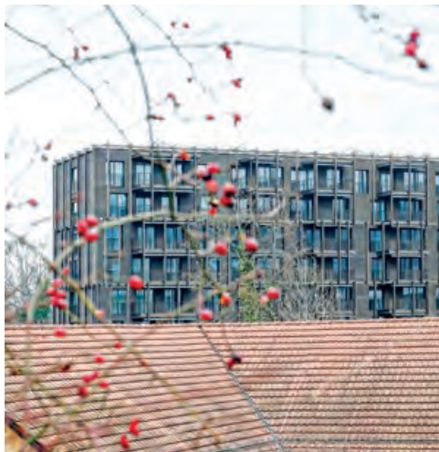
Piertzovanis Toews, Neubau Teichweg Wohnen, Münchenstein © Piertzovanis Toews
