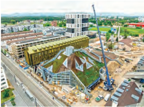
Baustellensituation, April 2026 © Franklin Grüne Mitte GmbH
